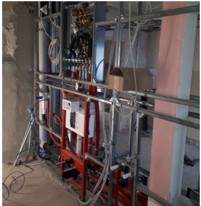
Haus 52, 1. OG rechts, Installationswand Bad/Küche
