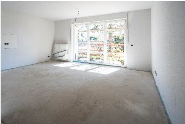
Haus 7, EG: Wohnbereich
