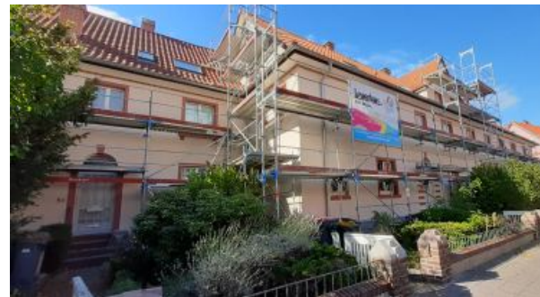
Damaschkestr.51-61 während Sanierung
