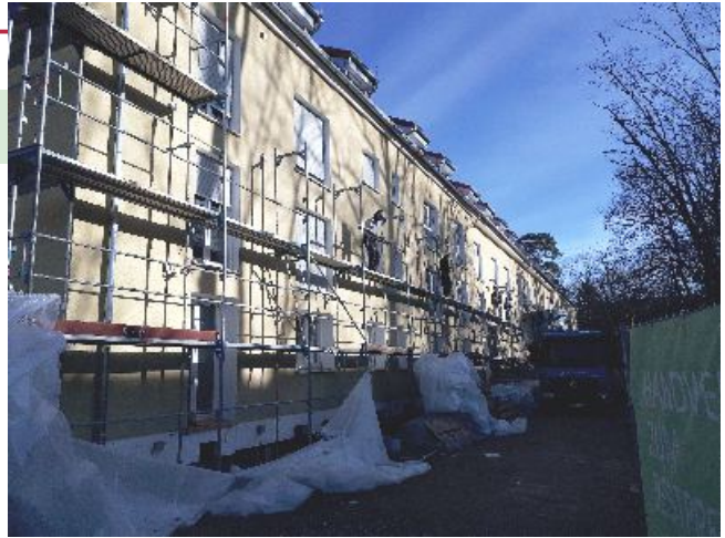
Die Südfassade Haus 60-66 wird „ausgepackt“
