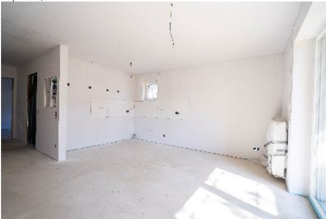
Haus 7, EG: Ess- u. Küchenbereich
