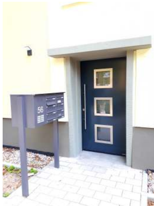
Neu gestaltete Eingangsbereiche
