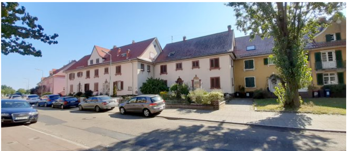
Foto: Damaschkestra e 56-66, saniert
